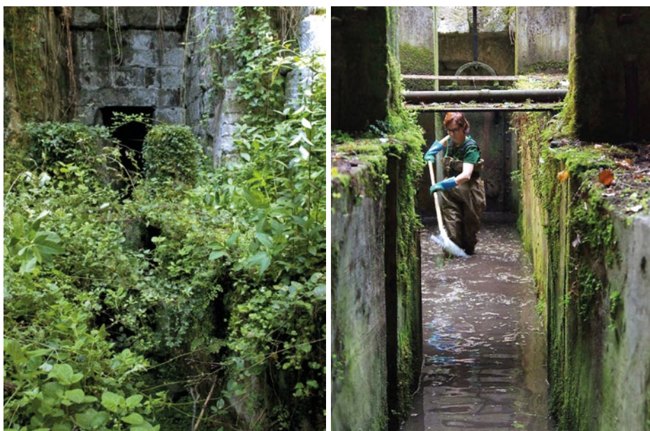
Fig. 19 – La ripulitura straordinaria dell'incile. A sinistra, invaso dalla vegetazione (foto Roberto Palombarani, per gentile concessione). A destra, durante l'intervento condotto nell'estate 2013 dai ricercatori Hypogea, sotto la vigilanza degli operatori del Parco dei Castelli Romani, nell'ambito della manifestazione "Puliamo il Buio" della Società Speleologica Italiana
