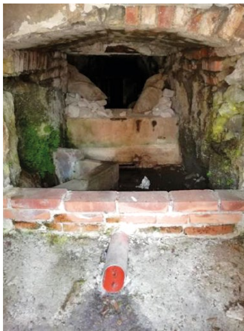
Fig. 17 Nel 2017 iniziano i lavori, i tecnici comunali eliminano il muretto che ostruiva l'accesso all'emissario oltre la grata e innalzano la soglia per creare un modesto invaso che consenta una alimentazione "costante" delle vasche
