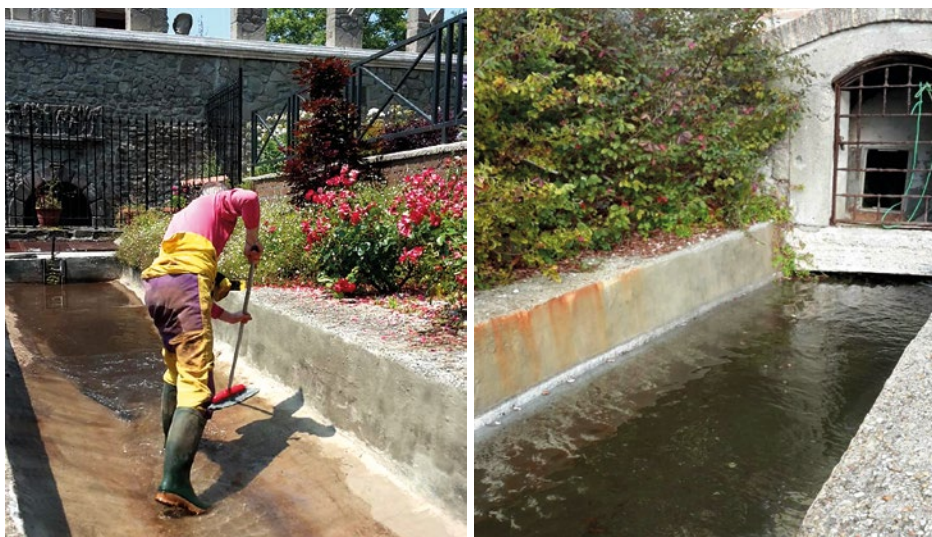
Fig. 15 e 16 – A sinistra, i vasconi vengono ripuliti prima di far affluire l'acqua. A destra, il 6 giugno 2015 grazie al nostro lavoro l'acqua sgorga di nuovo dall'emissario verso i vasconi
