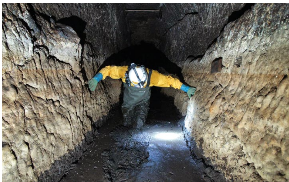
Fig. 13 – Il fango presente all'incile e in un lungo tratto intermedio del condotto
