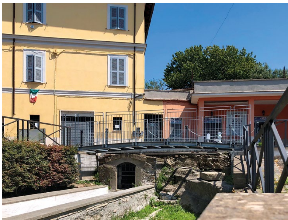
In alto, la passerella vista dal lato della strada. In basso, in relazione alla bocca dell'Emissario
