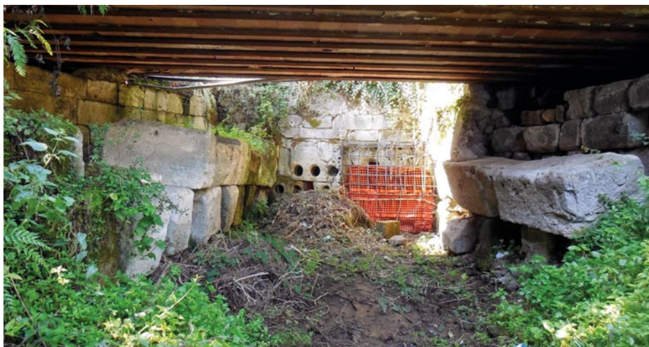
Fig. 3 – La camera dei doppi filtri in pietra ora sotto la strada
